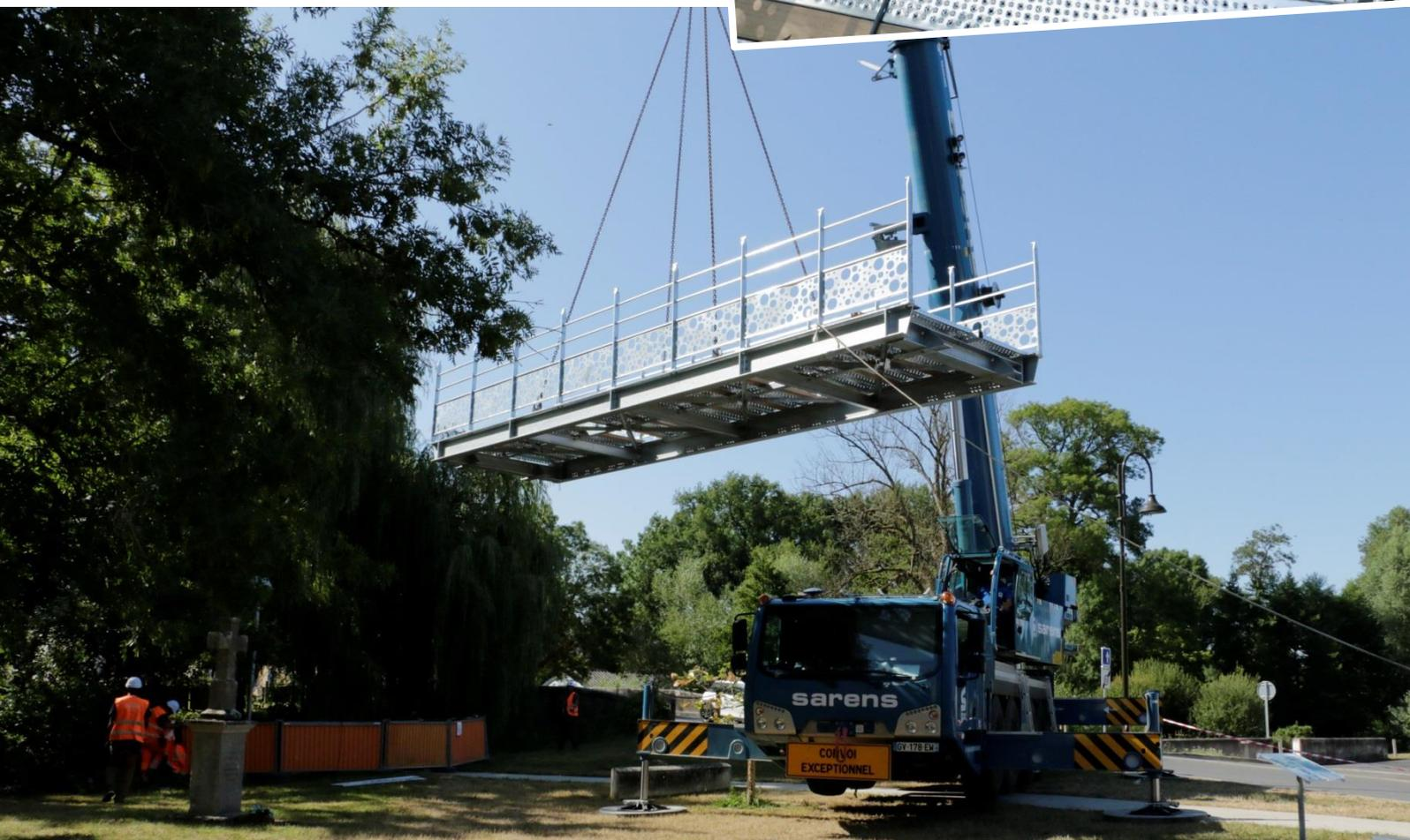
Une grue hydraulique d'une capacité de 80 tonnes, pilotée avec une précision extrême
