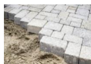
PAVAGE SUR LIT DE SABLE
