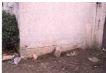
Fissuration horizontale
